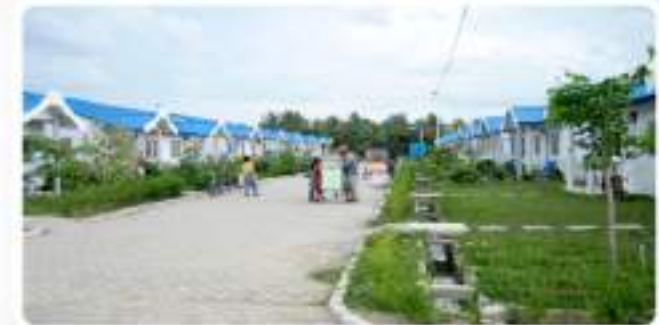
Perumahan Cinta Kasih Tzu Chi Panteriek, Aceh
